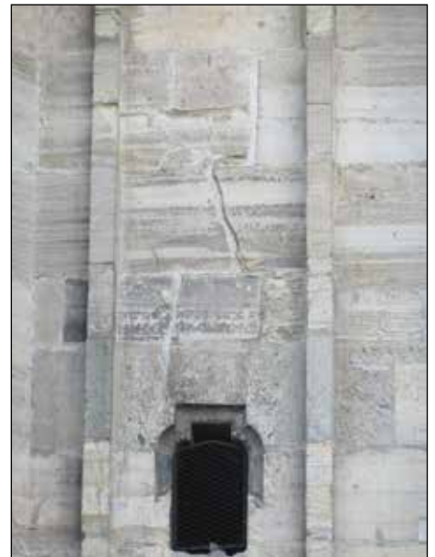
■ 5. kép: Közel függőlegesen eltört és szétcsúszott kváderek a déli mellékhajó falába illesztett lépcsőház ablaka fölött. © KÁZMÉR Miklós
