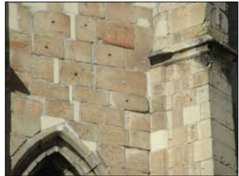
■ 4. kép: A fal síkjával párhuzamos rengés hatására egymástól eltávolodott kváderek közeit keskeny kőcsikkokkal töltötték ki a restaurálás során. A támpillérral szomszédos egyik tömb kismértékben elfordult: jobboldali széle néhány centiméterrel közelebb került a szemlélőhöz. © KÁZMÉR Miklós
