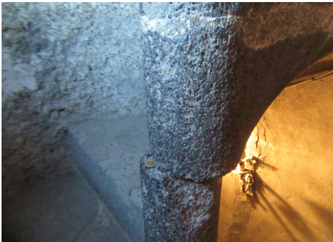
4. ábra. Csigalépcső elcsúszott lépcsőfokai. Nagyvázsony, Kinnisi-vár, lakótorony. Mércse: 100 Ft-os pénzérme, átmérője 24 mm. #0376.
