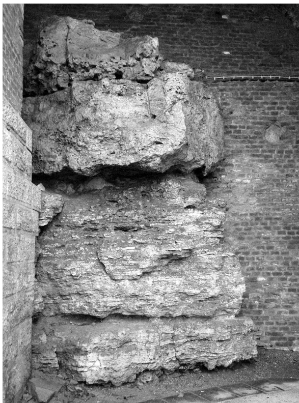
5.1. ábra. A mészkőplató rétegei a Halászbástya Kapucinus-lépcsője alatt. Alul a vékonyan rétegzett, tetarátás mészkő látható, rá települve a vastagpados tavi mészkő.
