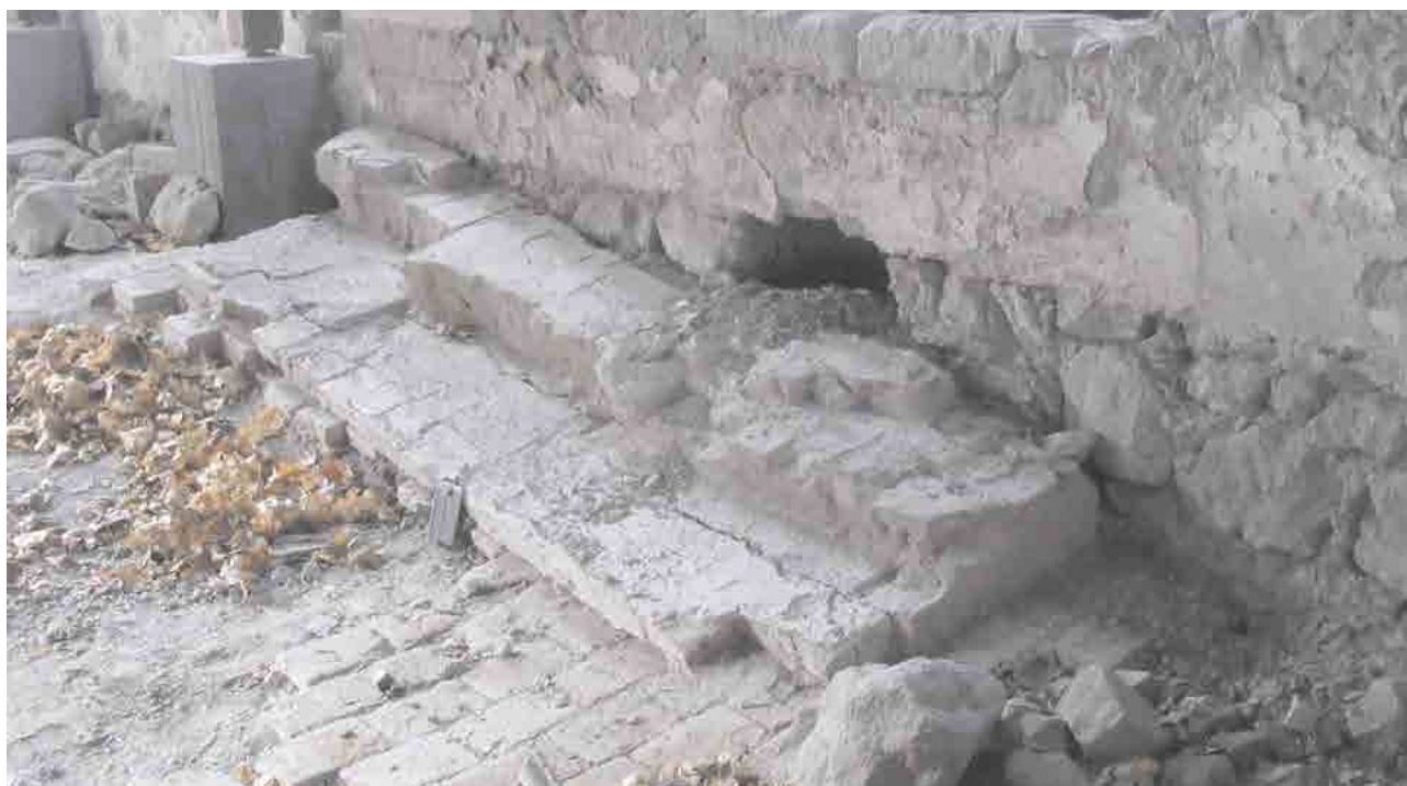
3. ábra. Leszakadt lépcső a kerengő északnyugati részén. A padlóval együtt lesüllyedt két lépcsőfok eredetileg a falon megmaradt harmadik alá illeszkedett. A süllyedés mértéke mintegy 70 cm
