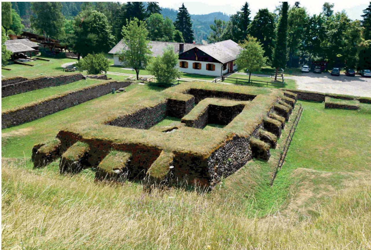
4. ábra. A Virunum melletti Magdalensberg (Karintia) római kori szentélyének alapfalai. A szabálytalanul elhelyezett, eltérő méretű támpillérek arra utalnak, hogy a szentély falai szerkezeti károsodást szenvedtek (KÁZMÉR et al. 2022)
